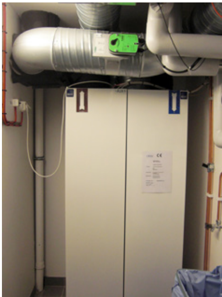
Kompakt och lättplacerat aggregat – 0,54 m 2 golvyta. Placerad i nisch på plan 3.
