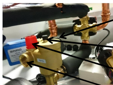
Tryckmätare Luftningsnippel Övertrycksventil Utlopp. Kopplas till golvbrunn eller liknande.
