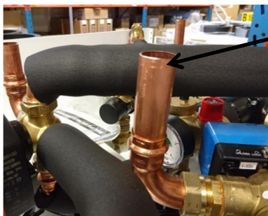
Anslutning av framledning till radiatorer/golvvärm. 28mm kopparrör. Kan anslutas med press- eller klämringsskoppling.
