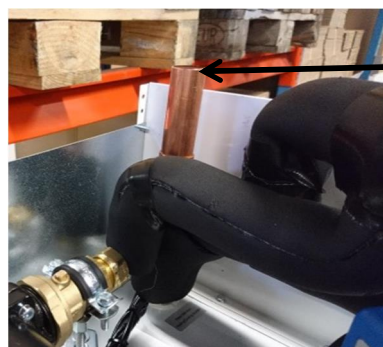
Anslutning av returledning radiatorer/golvvärm. 28mm kopparrör. Kan anslutas med press- eller klämringsskoppling.
